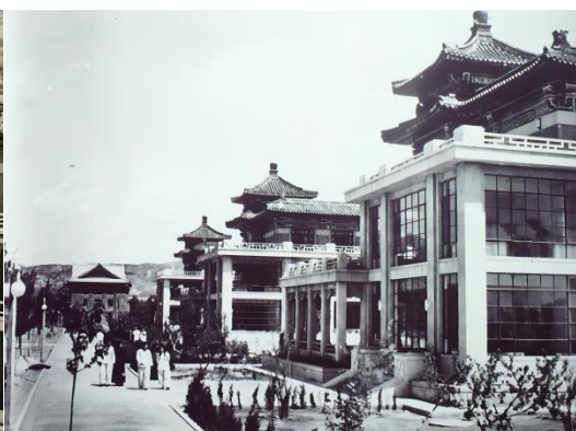
图 18 亚洲学生疗养院病房楼西南端 (图源国医小镇)
