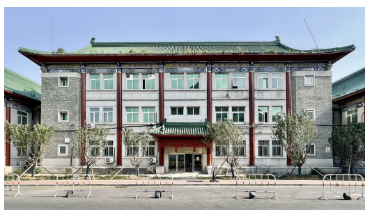
图 5 亚洲学生疗养院新门诊大楼 (作者自摄)
