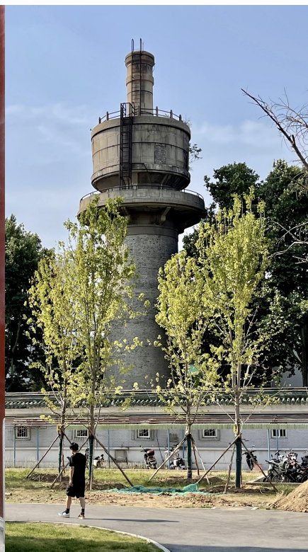
图9 水塔及锅炉房 (作者自摄)
