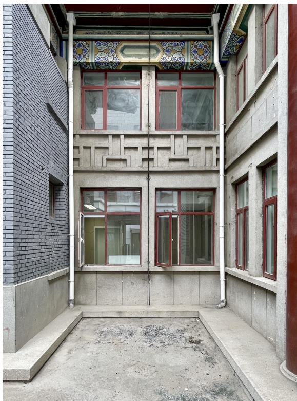
图8 中国医学科学院整形外科医院行政楼原磨石墙面与新加固的蒙古灰石材墙面对比 (作者自摄)
